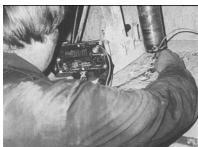
Slika 4 - Vađenje kerna u cilju određivanja postojećeg stanja napona u betonskoj konstrukciji
